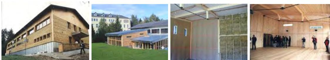
**International: 2002 Lasttragendes 2-geschossiges Stroh Passivhaus Arch. Werner Schmidt in Graubünden Dissentis auf 1300 m Höhe, geplant für 750 kg Schneelast /m<sup>2</sup>**
