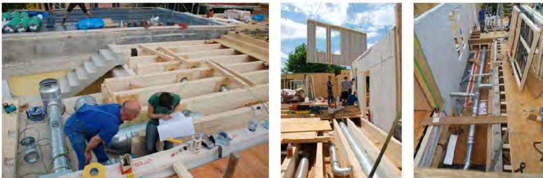
Fotos: Erstellung des neuen Obergeschosses, Zwischenboden mit Lüftungsrohren
