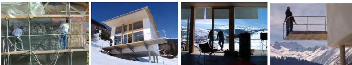
Sanierung Haus Lesch BM Hegedys 2002, vor Mauerwerk eines Bauernhauses wurde durchgehender Strohschirm angebracht.
